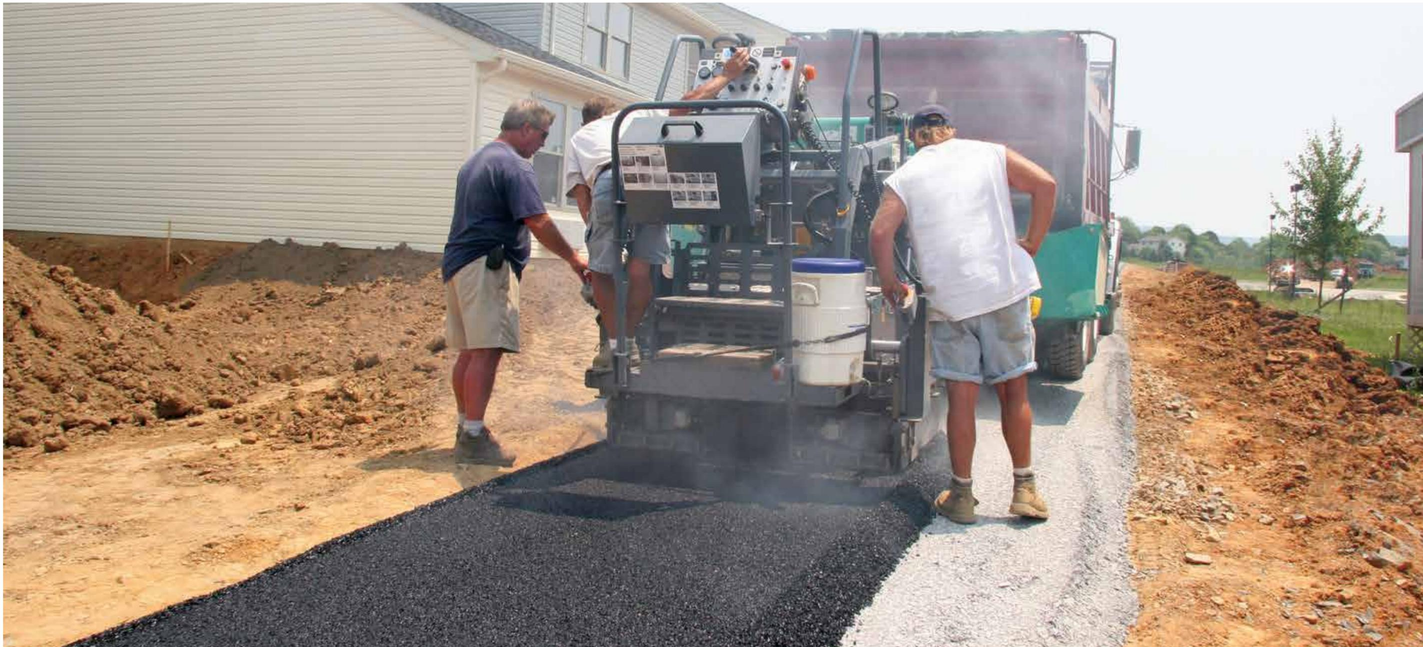
Il banco di stesa AB 200 V è concepito appositamente per l'uso con la SUPER 700. Ha una larghezza base di 1,1 m ed è estensibile idraulicamente fino a raggiungere una larghezza di 2 m. Con l'aiuto di elementi di allargamento rigidi, l'AB 200 V può essere portato ad una larghezza massima di stesa di 3,2 m. Queste misure predestinano la combinazione di SUPER 700 e AB 200 V alla costruzione
