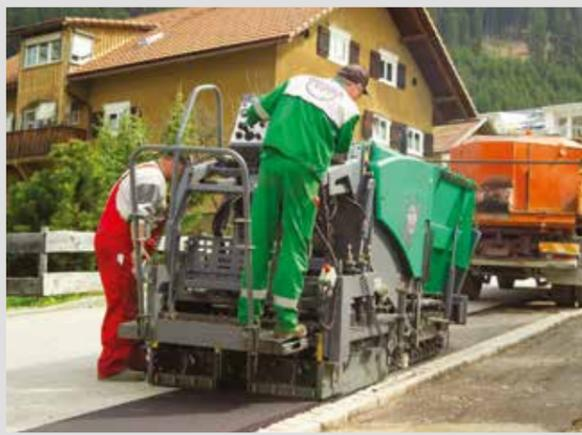
Riempimento di trincee di canalizzazione
