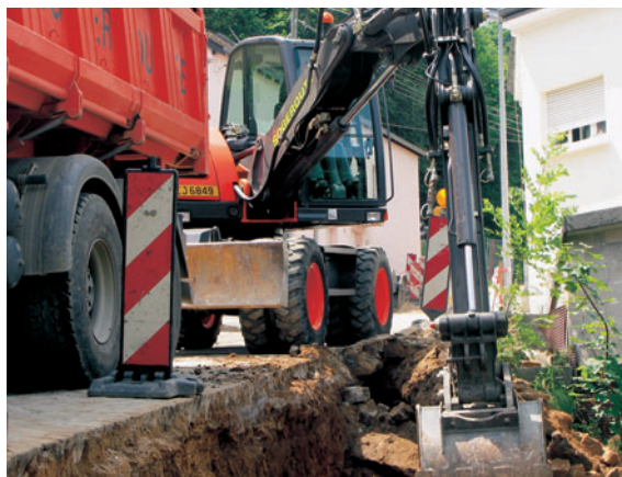
▲ Scavo della trincea con benna da 900 mm, carico del camion
