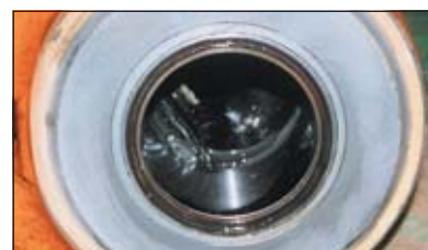
rivestimento termico WC
